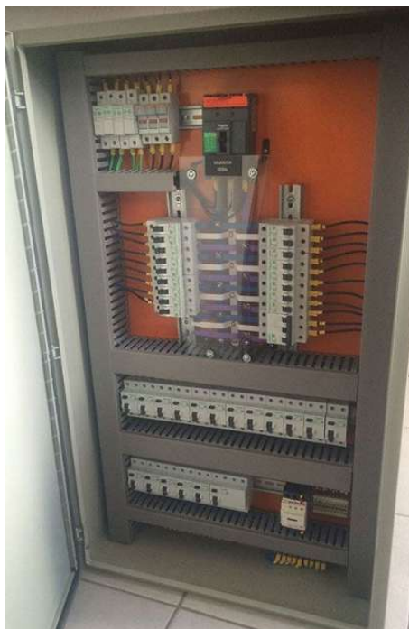
Figura 41 - Painel/Quadro de distribuição de energia elétrica
