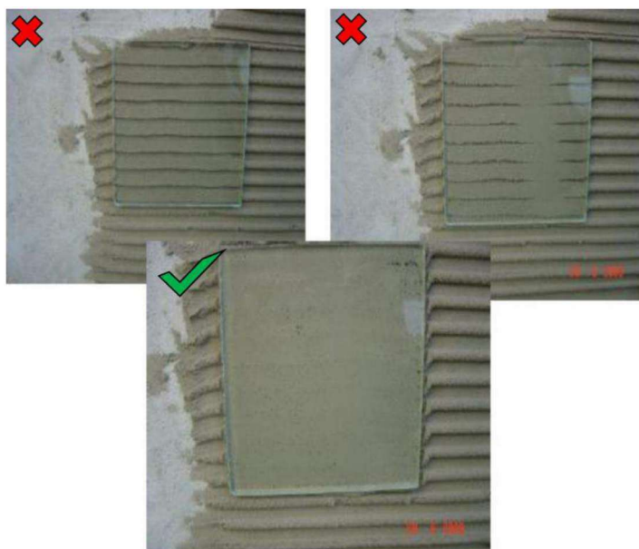
Figura 78 – Assentamento de peças de revestimento
